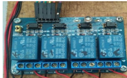
Gambar 19. Kondisi Relay OFF
