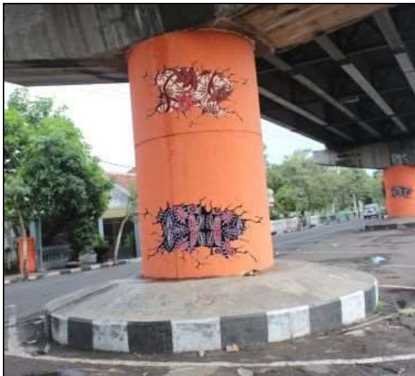
Gambar 6. Implementasi Ambient Pada Pilar Jembatan Gajah Mada (Lestari, 2016)
